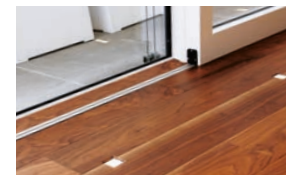
Binario scorrevole, installato a scomparsa nel pavimento.
